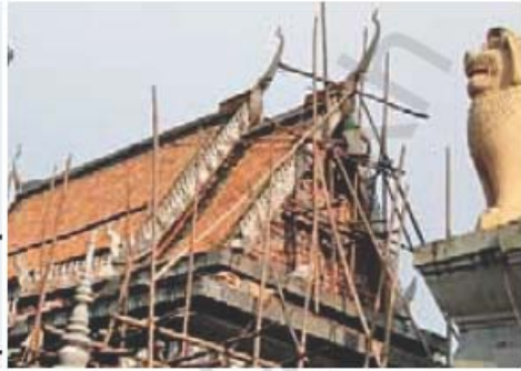
ជហ្គាចាស់មានសភាពទ្រុឌទ្រោមបែកបាក់មួយចំនួន និងមួយចំនួនទៀតទ្រុកទៅឆ្វេង ឬទៅស្តាំ មិនត្រូវជួរ និងការដំឡើងជហ្គាថ្មី
