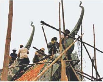
ជហ្គាចាស់មានសភាពទ្រុឌទ្រោមបែកបាក់មួយចំនួន និងមួយចំនួនទៀតទ្រុកទៅឆ្វេង ឬទៅស្តាំ មិនត្រូវជួរ និងការដំឡើងជហ្គាថ្មី
