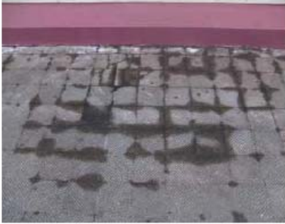
រូបភាពកំរាលការ៉ូដ្រូវដើរជុំវិញព្រះវិហារប្រេះ និងស្រទាប់បាយអក្រាលការ៉ូហើប និងជ្រាបទឹក ពុកជុយខូចគុណភាព (មុនពេលជួសជុល)
