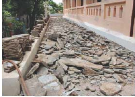
រូបភាពកំរាលការ៉ូដ្រូវដើរជុំវិញព្រះវិហារប្រេះ និងស្រទាប់បាយអក្រាលការ៉ូហើប និងជ្រាបទឹក ពុកជុយខូចគុណភាព (មុនពេលជួសជុល)
