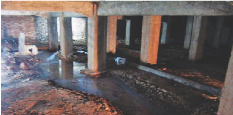
ស្ថានភាពទឹកដក់ក្នុងលេណគ្រឹះ ដោយសារការលេចធ្លាយពីបំពង់ទឹកចាស់
